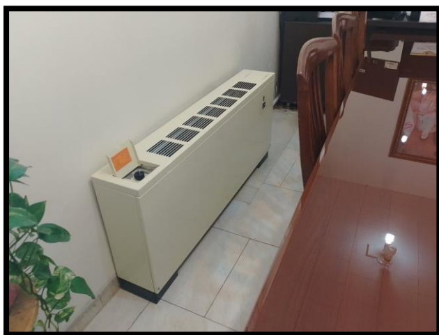
تعویض فن کوئل های فرسوده و استفاده از فن کوئل های نو
