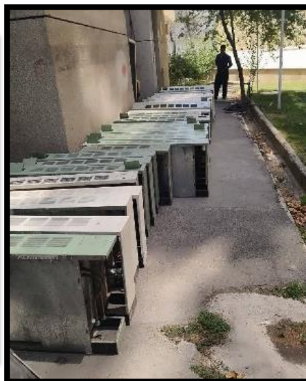
تعویض فن کوئل های فرسوده و استفاده از فن کوئل های نو
