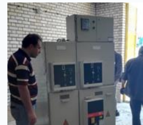
نوسازی پست برق سایت شرقی و تبدیل آن از ۳۶۰ کیلو وات به ۱۰۰۰ کیلو وات
