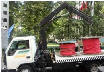
احداث پست برق COMPACT در سایت اصلی
