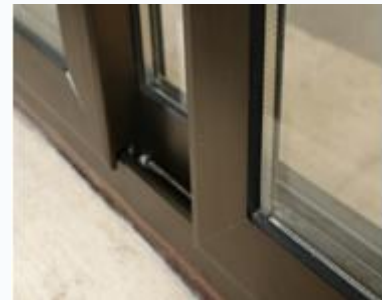
تعویض پنجره های دانشگاه از معمولی به دوجداره در حدود ۳۵ درصد ساختمان های دانشگاه و نصب درب های اسلایدینگ برای ۱۰ ساختمان قدیمی دانشگاه
