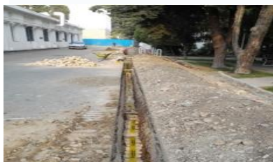
تعویض کابل ۲۰ کیلو ولت پست های داخلی سایت شرقی
