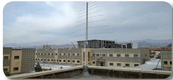
آنتن LPDA ساخته شده از آلیاژ آلومینیوم آنودایز شده‌ی فوق مقاوم در برابر خوردگی برای فرکانس‌های ۳۰ تا ۸۰ مگاهرتز
