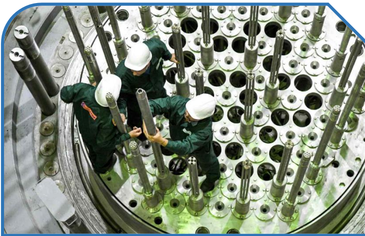
تصویر ۴. مهندسان در حال نصب میله‌های کنترل در یک نیروگاه هسته‌ای. [۱۰]
